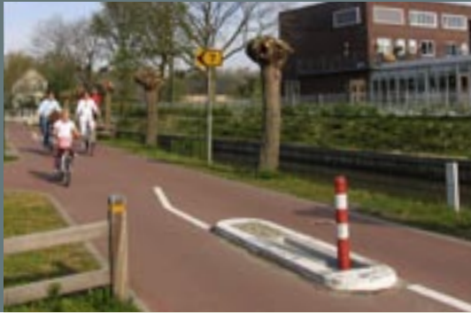
Middengeleidertje ook in gebruik om een neergeklapt paaltje in te verzinken.
